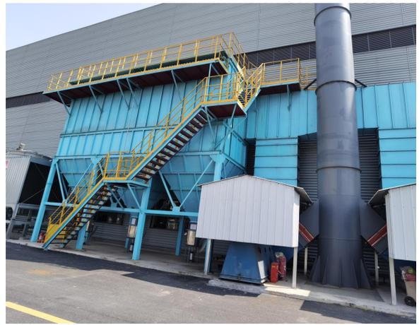
熔化废气布袋除尘器
