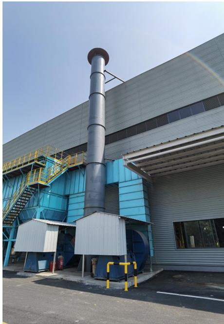
熔化废气 25 米高排气筒
